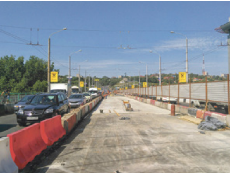
■ Ремонт центральной части моста завершится 1 августа
