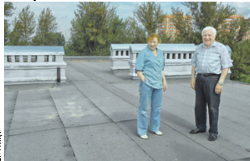
Жильцы дома на проспекте Ленина, 24, осматривают крышу, отремонтированную в кредит
