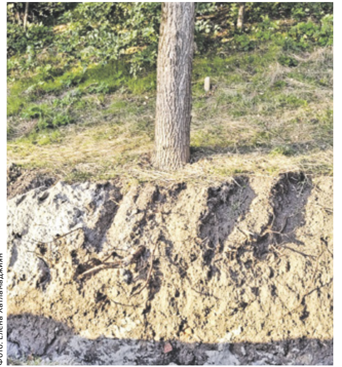
■ Многочисленные траншеи обнажили корневую систему деревьев
