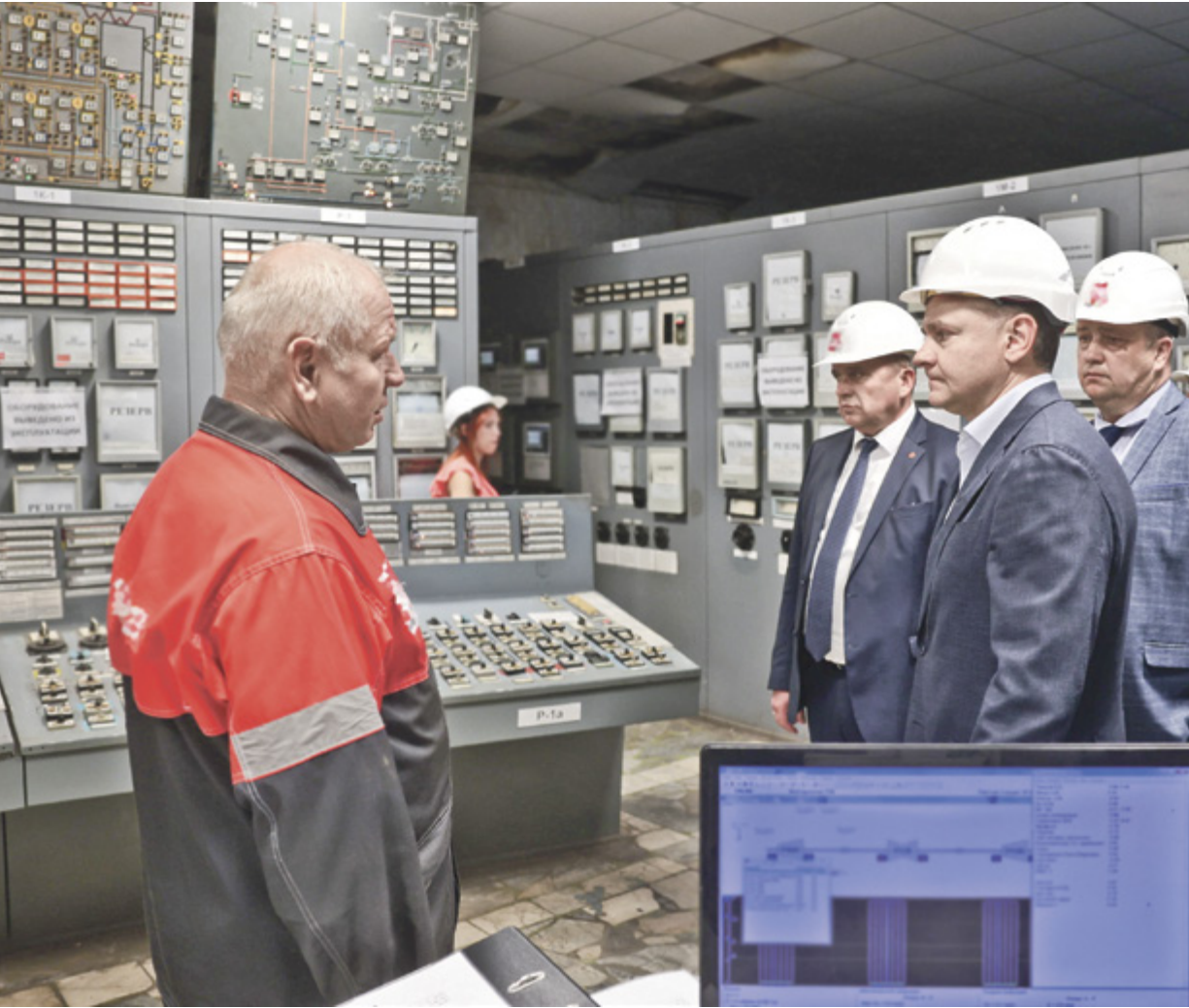
■ В сентябре глава региона проинспектировал ход аварийно-восстановительных работ на теплоэлектроцентрали в Волгодонске
