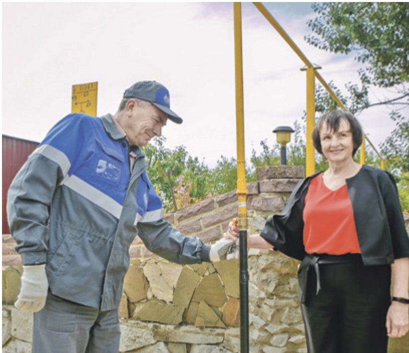
■ Хозяйка первого дома хутора, к которому подключен газ, Любовь Черенкова сама открыла кран на газовой трубе
