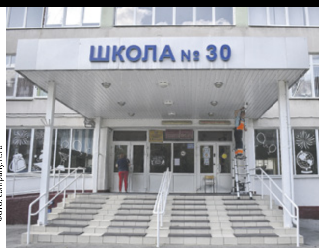
■ Идет монтаж видеоборудования на входе в одну из ростовских школ
