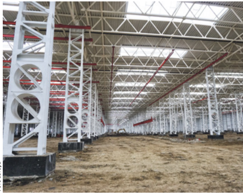
Будущий цех тракторного завода
