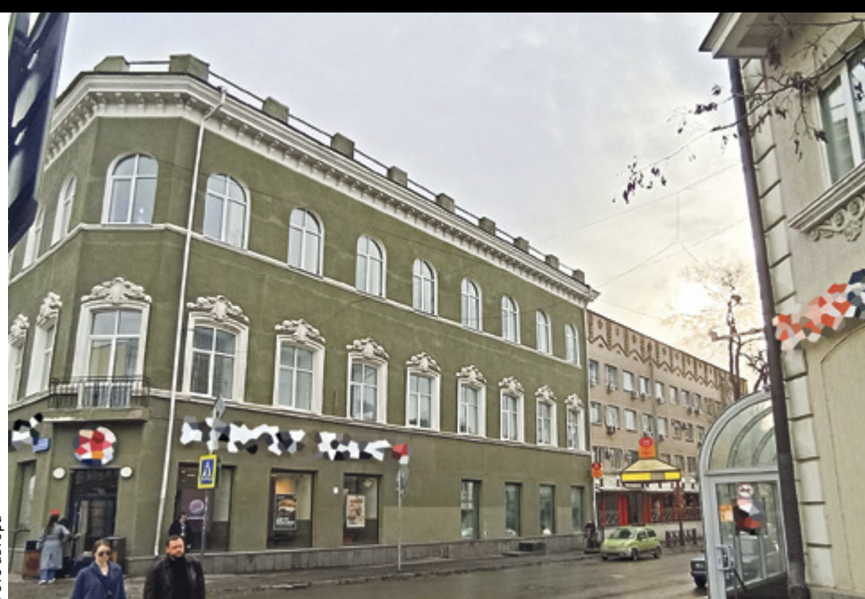
■ Если снести здание на Буденновском, 17, то будет изменен ансамбль всей застройки проспекта Буденновского от Московской и выше
