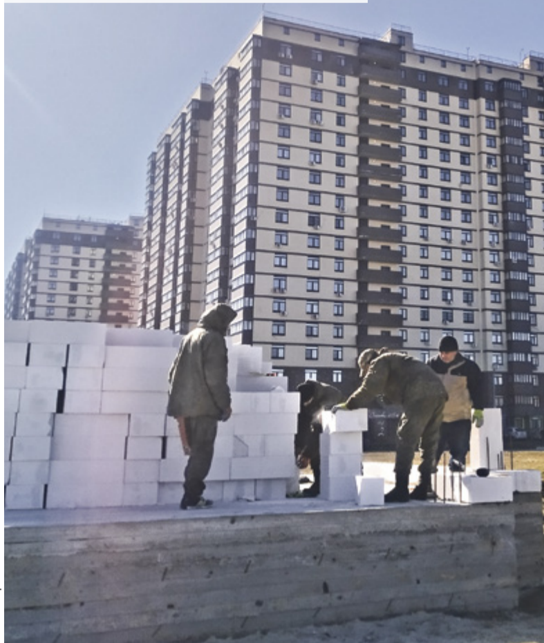
Кладку на православной часовне ведут строители-мусульмане
