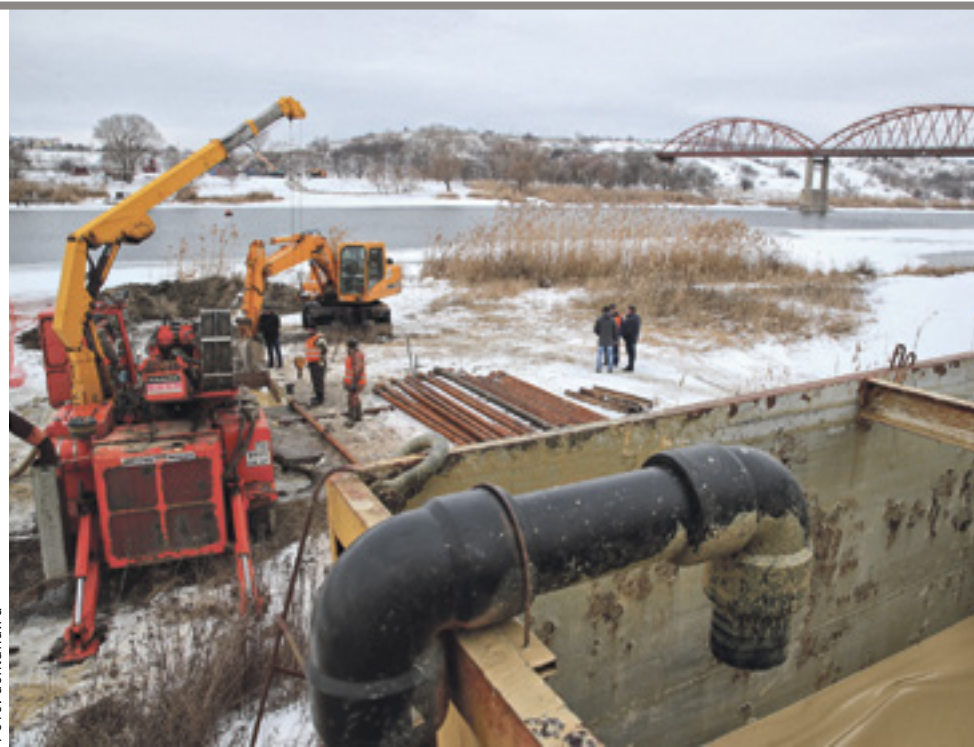
■ Работы по восстановлению дюкера через реку Северский Донец
