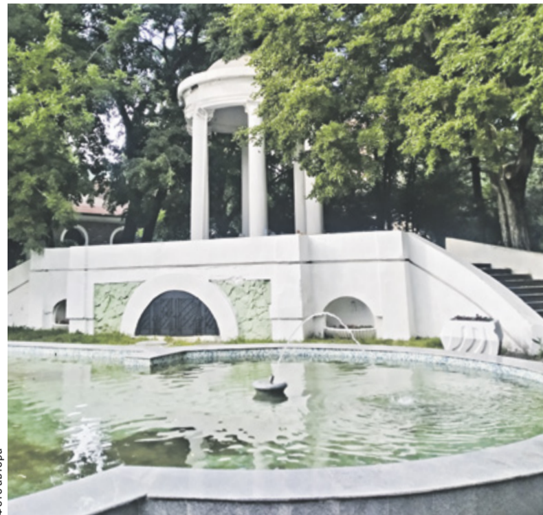
В парке 1 Мая (бывший сад летнего коммерческого клуба) сохранилась ротонда, правда, уже в упрощенном виде
