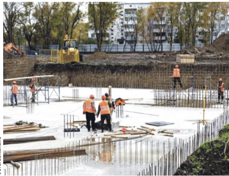
В Авиагородке строители уже закладывают фундамент для будущей школы
