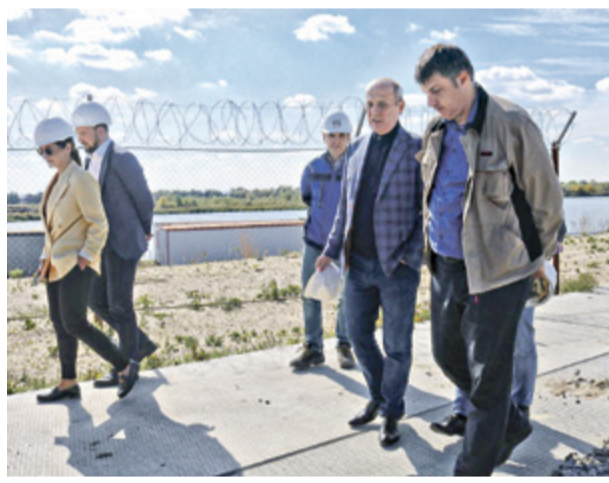
Заместитель министра транспорта РФ Василий Десятков побывал на стройплощадке Багаевского гидроузла
