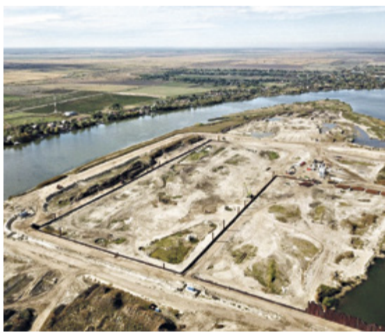
На острове Арпачинском подрядчик занимается устройством котлована под основные сооружения гидроузла
