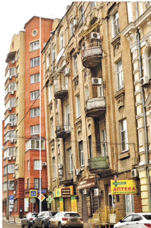
■ Грунт под фундаментом старинного дома на Шаумяна, 13 «поплыл» двадцать лет назад
