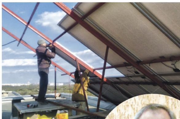
■ Установленная на крыше дома солнечная электростанция рассчитана на производство 18 тыс. кВт·ч электричества в год
