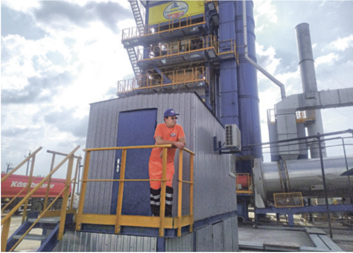
■ На заводе автоматизированы все технологические процессы приготовления асфальтобетонных смесей
