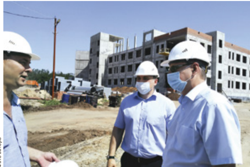
■ Заместитель губернатора Вадим Артемов (справа) проинспектировал ход строительства школы в хуторе Старая Станица Каменского района
