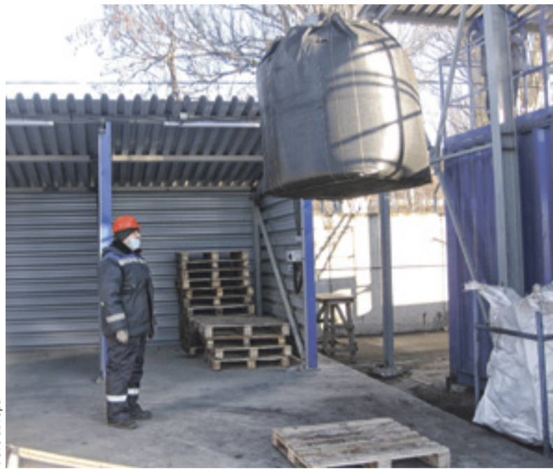
Оборудование по дозированию активированного угля размещено на площадке водозабора
