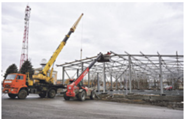
■ Каркас будущего катка уже испытан на прочность
