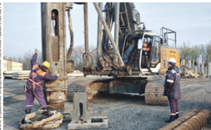
■ В строительстве пятого этапа обхода Аксая задействованы 300 единиц техники и свыше 1000 человек
