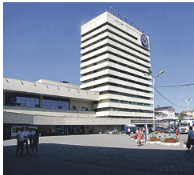
Здание Главного железнодорожного вокзала
