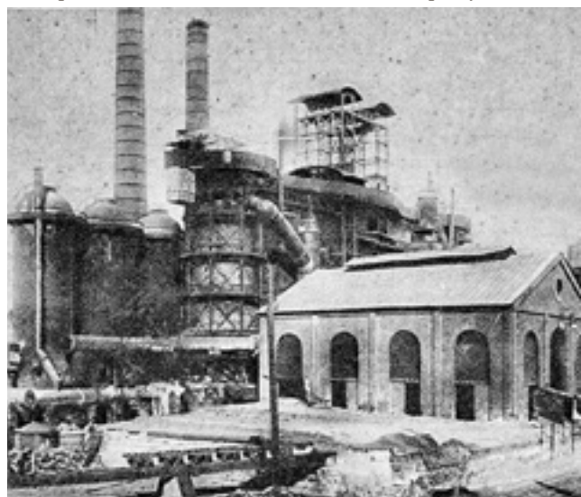
Доменный цех металлургического завода. Макеевка начала XX века
