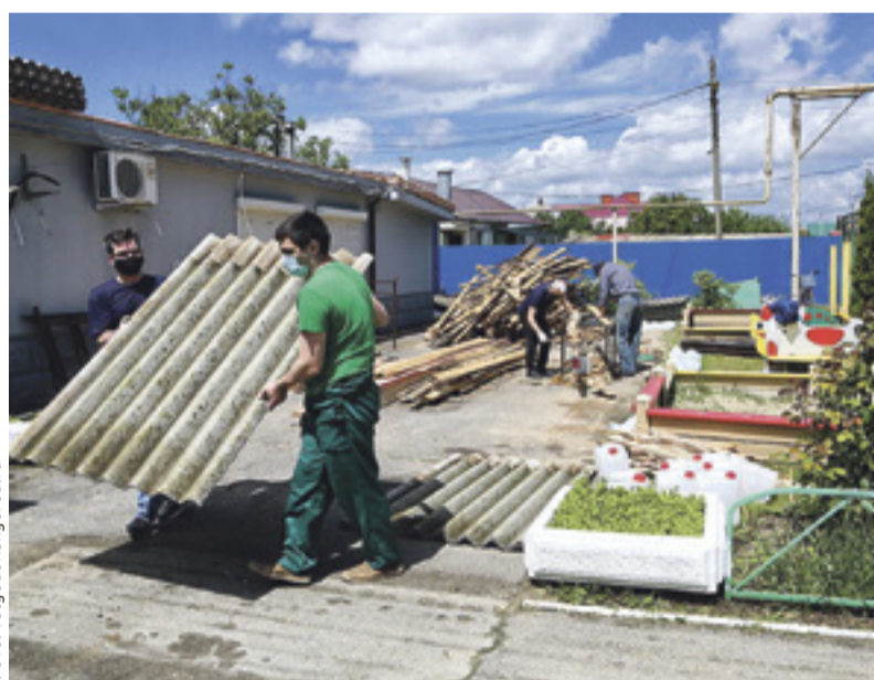
Идет ремонт в филиале ДК «Октябрь» в Красном Яру
