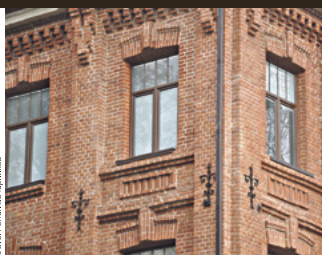
■ Фасад перинатальной клиники на Соборном, 58, по-видимому, спасло чувство стиля владельца здания, и кирпич очистили грамотно
