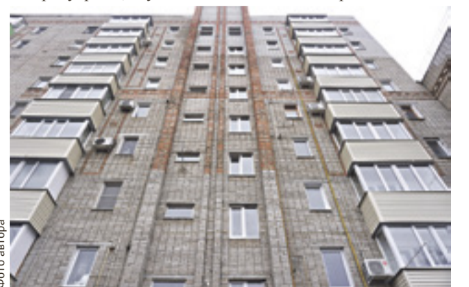
■ Восстановленный подъезд дома
