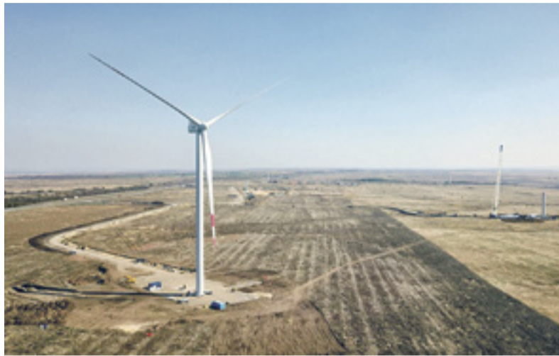
На Сулинской ВЭС завершили монтаж первой ветроэнергетической установки
