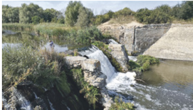
■ Бывшая (разрушенная) плотина реки Кундрючка
