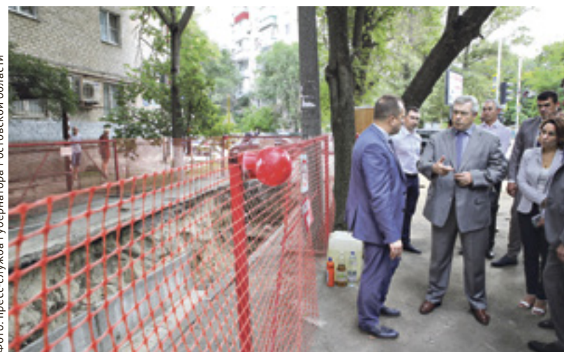
■ Губернатор проинспектировал работы по замене теплотрассы в Соборном переулке донской столицы
