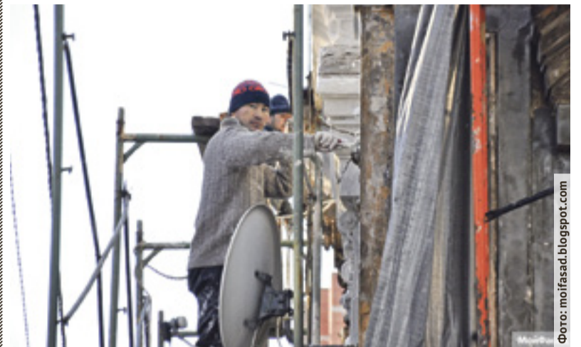
Строителям выгодно делать более простую работу
