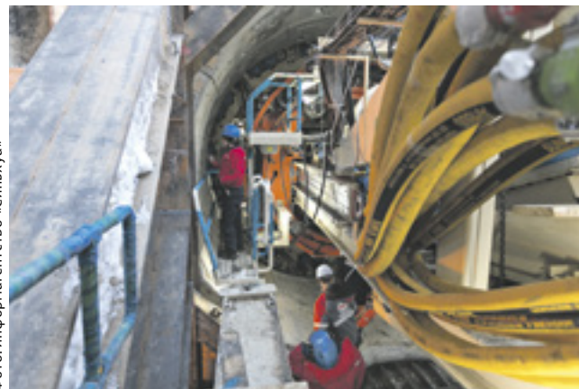
■ Тоннелепроходческий щит «Мария» используют при строительстве подземки в Москве
