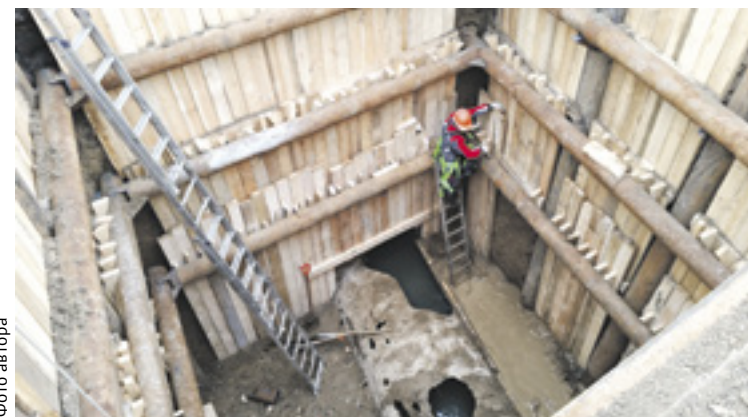
Работы по восстановлению аварийных участков канализационного коллектора продолжаются
