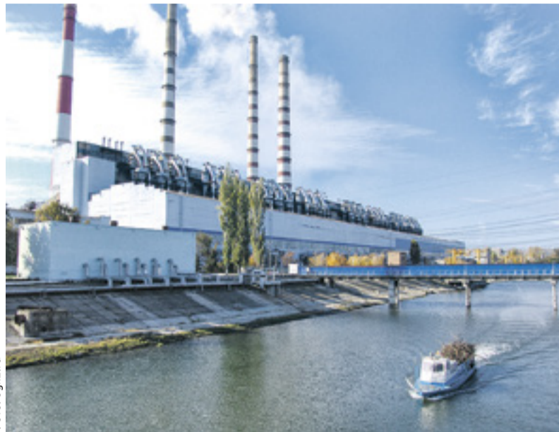
■ Новочеркасская ГРЭС потребляет в год от 3 млн до 4,5 млн т угля, то есть большую часть угля, добываемого в области
