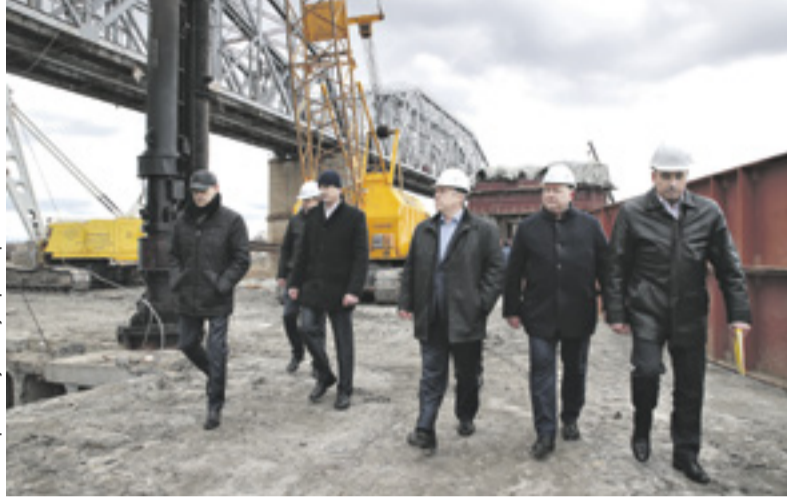
К концу года в Каменске построят новый мост через Северский Донец длиной более 1 км
