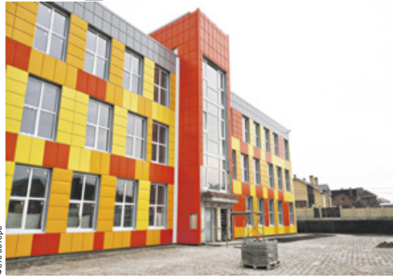
■ Фасад строящейся школы в поселке Янтарном
