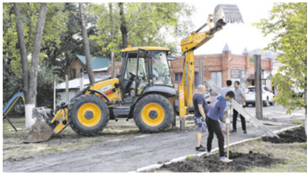
■ Работы по благоустройству парка «Юность»
