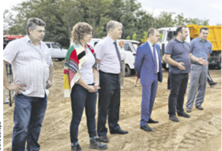
■ Министр ЖКХ Ростовской области Андрей Майер (третий справа) на строительной площадке Волгодонского МЭОК
