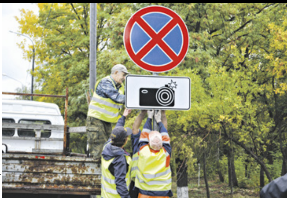
■ Дорожные знаки и таблички уже монтируют
