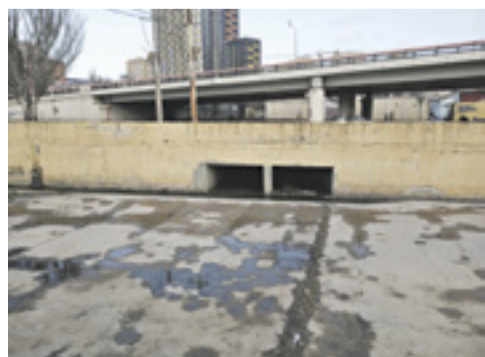
■ Выход подземной галереи в районе Главного автовокзала (Темерник)
