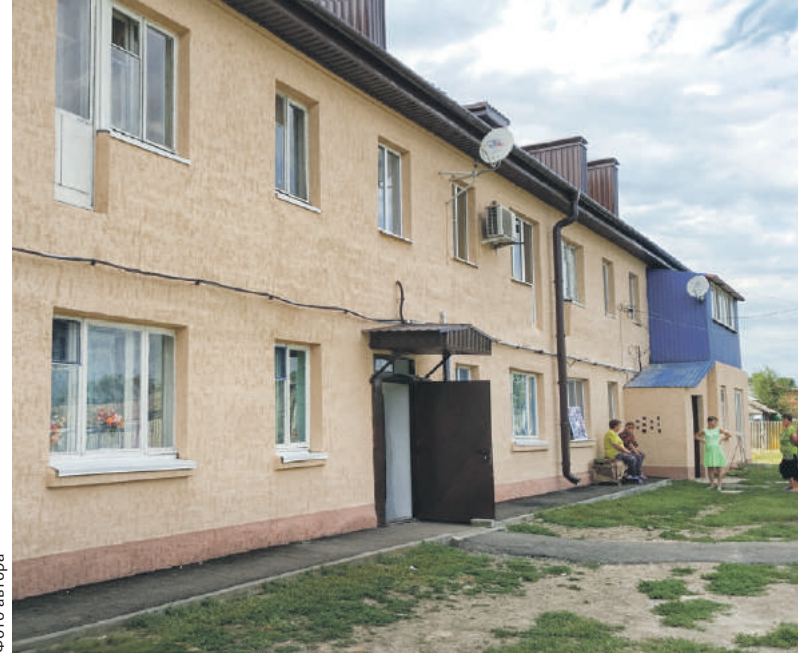
■ Таким стал дом в переулке Солнечном после капремонта
