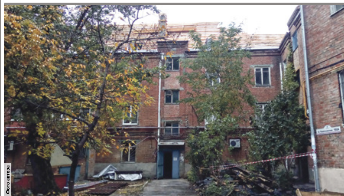
За ремонтом крыши на Буденновском, 102, проследит министерство ЖКХ
