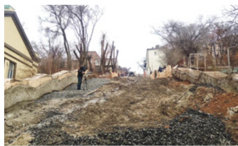
■ На Казанской лестнице с октября – ремонт
