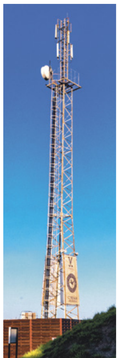
■ Значительные затраты на строительство сети приходится на зарубежное оборудование
